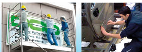
Pose sur site
